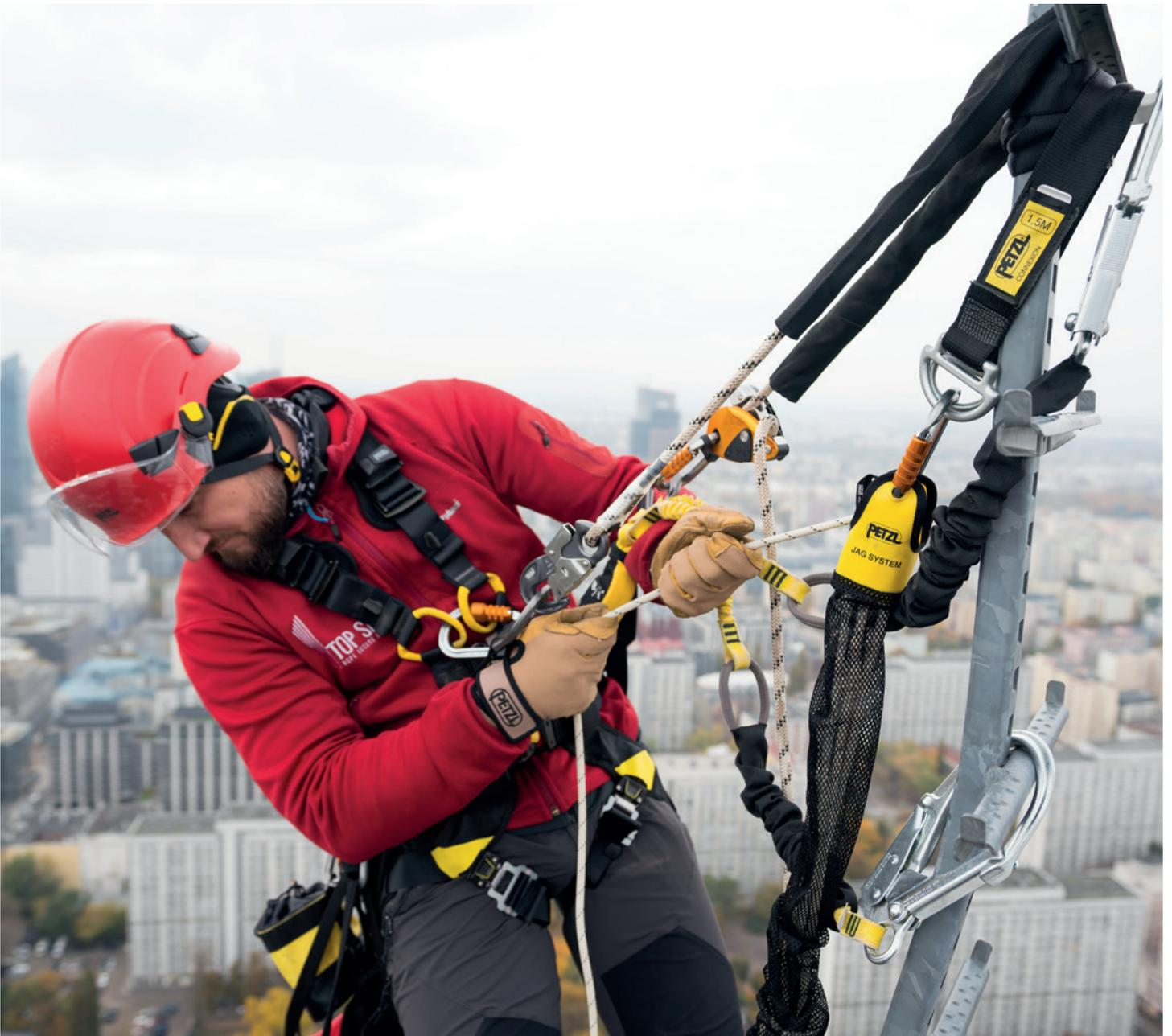
Der Petzl Custom Service bietet eine individuelle Ausführung des JAG RESCUE KIT an. Der Kunde kann die Farbe und die Länge des AXIS 11-mm-Seils (von 10 bis 185 Meter) wählen. Außerdem kann die Art der Verankerung, die Länge des Flaschenzugsets sowie das selbstbremsende I'D S- oder I'D EVAC-Abseilgerät mit Anti-Panik-Funktion gewählt werden. Das Set wird je nach Länge des gewählten Seils in einem entsprechenden Sack geliefert und ist sofort einsatzbereit.
